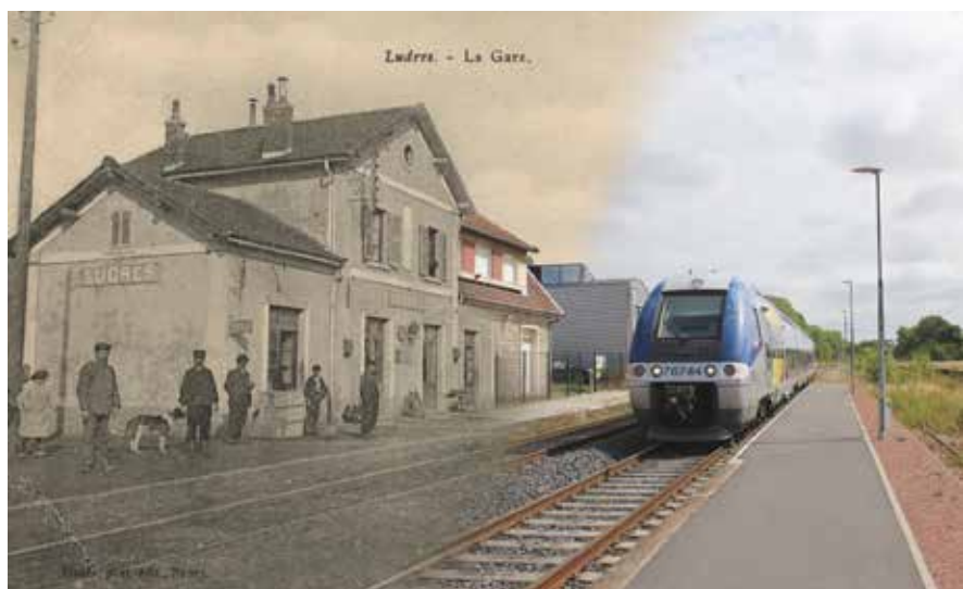
La gare va connaître une nouvelle évolution en devenant un Pôle d'Echanges Multimodal.
