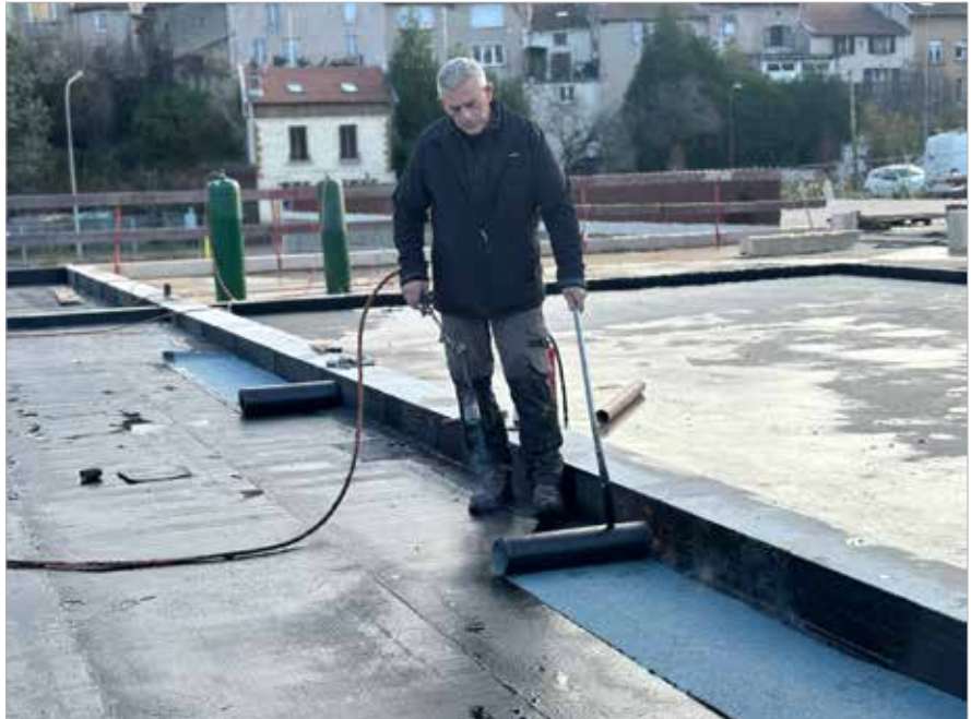
L'entreprise intervient sur de nombreux bâtiments, comme ici La Conserverie Lerebourg à Livردun avec la réalisation d'une étanchéité en résine de sol.
