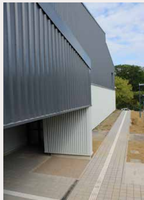
Un cheminement PMR a été créé pour relier l'entrée principale et l'entrée des sportifs.
