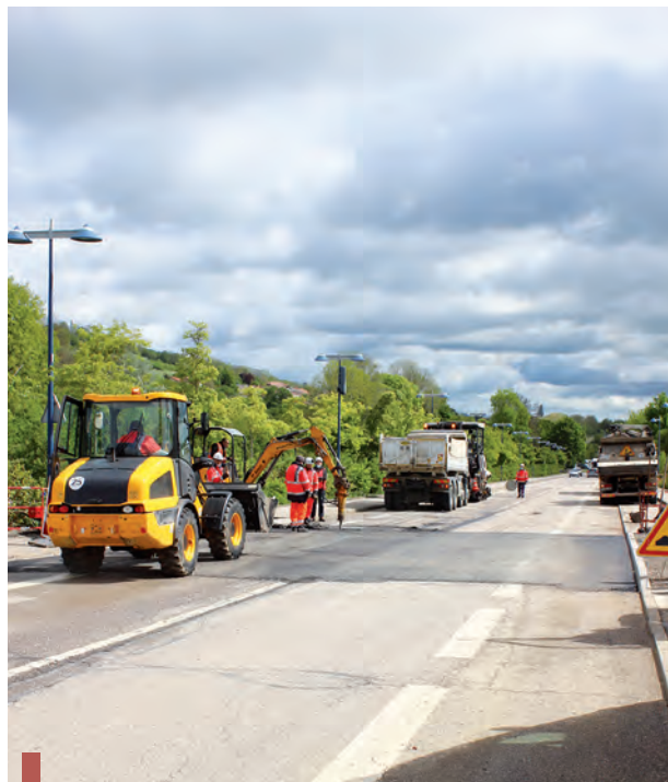
Un ralentisseur a été créé, rue Marvingt, pour sécuriser les accès au bâtiment.
